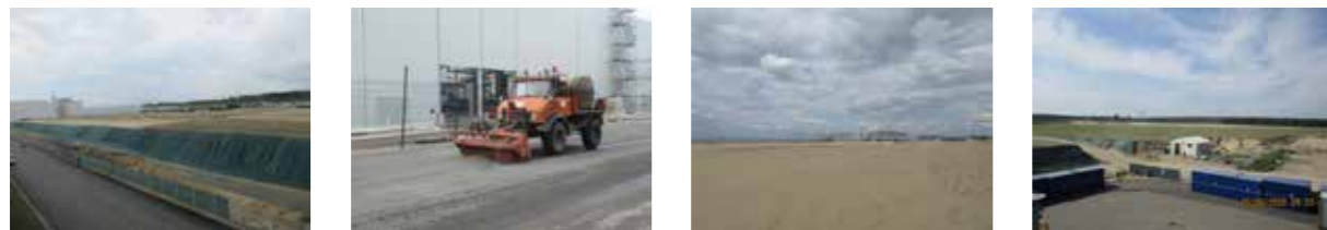
Humusszal fedett felület, locsolás, rézsű és védőfólia, illetve a száraz, porzó felület befüvesítése.
